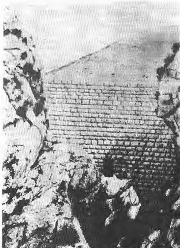
Сл. 11. Лучна брана за заустављање покретног наноса, висока 17 m (горњи ток бујице Шкурда, изнад Котора).
