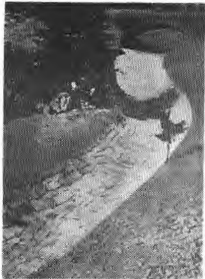
Сл. 14. Смањивање уздужног нагиба полукружном кинетом (горњи ток бујица Кримаљ). (Фото: А. Hofmann)
