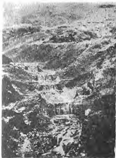
Сл. 13. Степенасте стабилизационе преграде са изведеном дренажом падине (Бујица Звиrhoњак, изнад Котора). (Фото: А. Hofmann)
