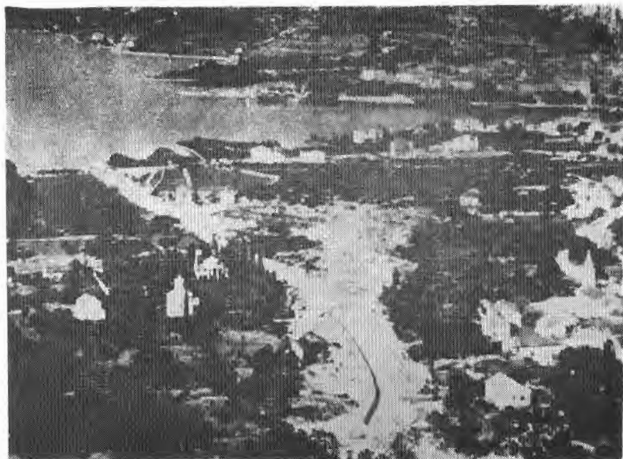
Сл. 10. Калдрмисани канал којим је бујица Звириоњак спроведена у море. (Фото: А. Hofmann)
