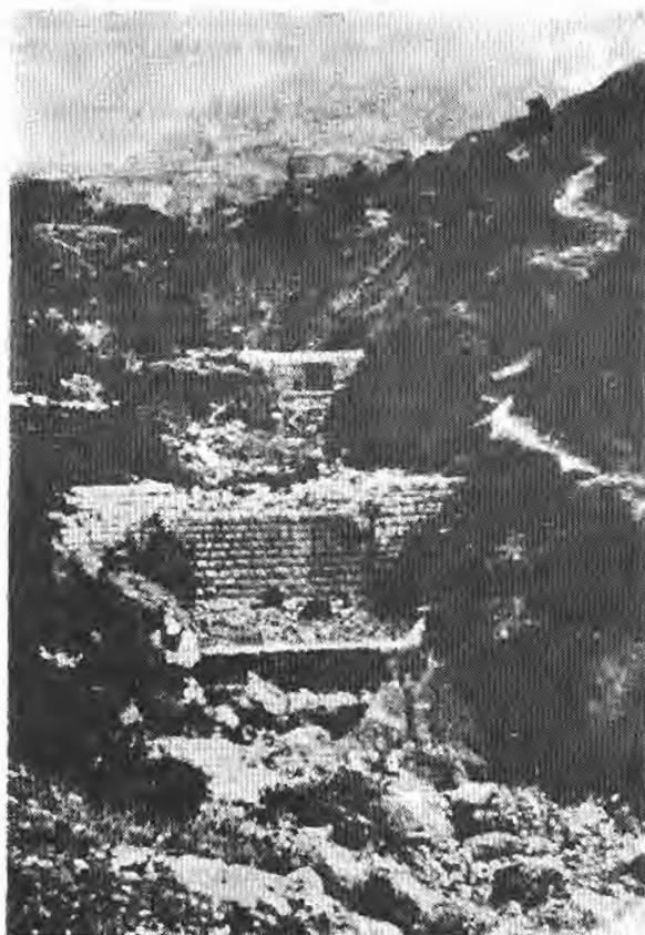
Сл. 15. Преграда и контрапреграда (бујица Звиrhoњак испод Тројице код Котора). (Фото: А. Hofmann)
